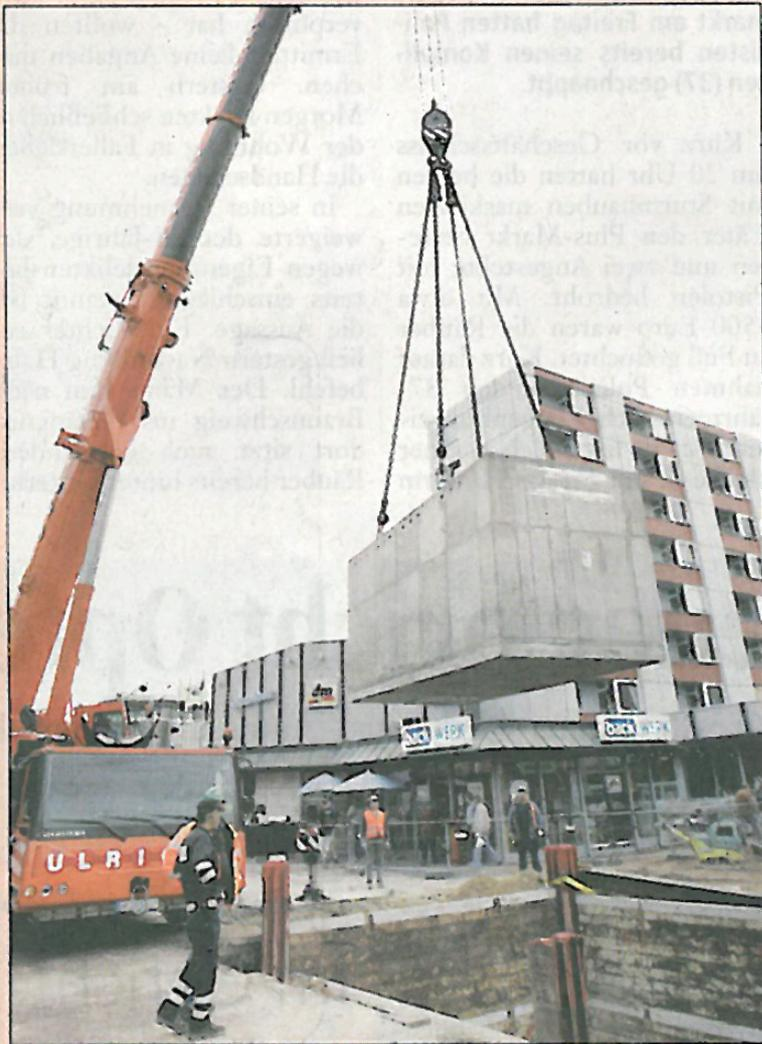
**Dicker Brocken am Kran: Das neue Verteilerbauwerk, das gestern eingesetzt wurde, wiegt zwölf Tonnen.** Photowerk (mar)
