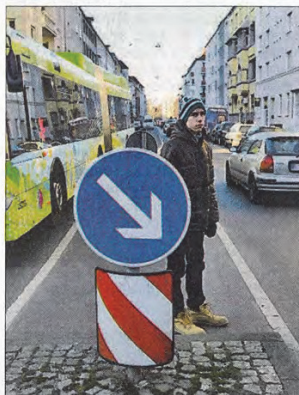
Zwei Verkehrsinseln werden demontiert, jedoch durch neue Querungshilfen ersetzt.
