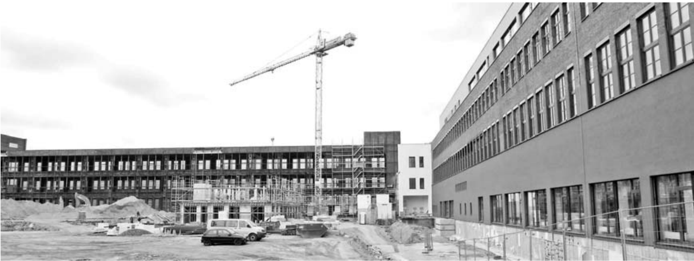
Fertigstellung in Etappen auf dem Hanomag-Gelände: Das Gebäude der Telekom (rechte Seite) ist bereits fertig, an den Räumen für die Windwärts Energie GmbH (hinten) wird noch gewerkelt.
