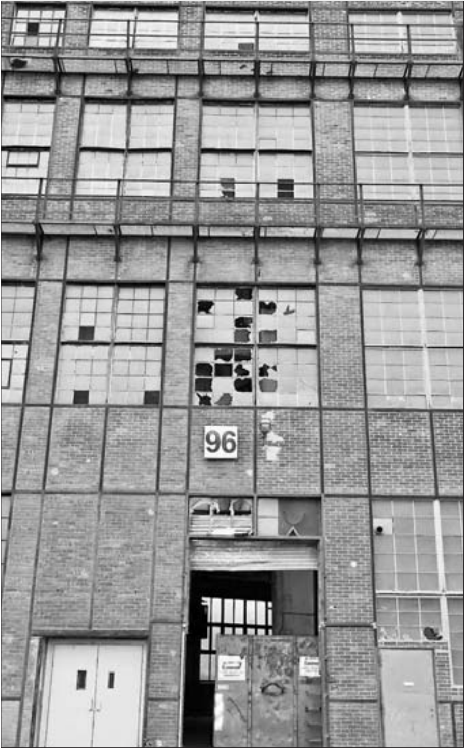
Noch ist das Gebäude an der Hanomagstraße nicht bezugsfertig, doch nach und nach sollen hier großzügige Wohnlofts entstehen.
