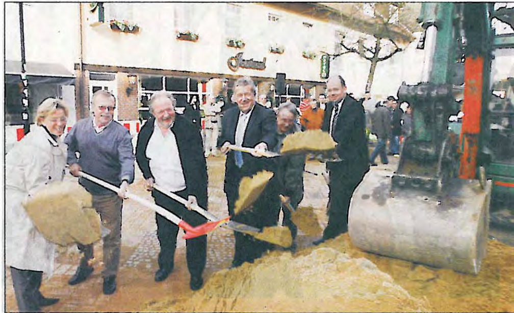
Erster Spatenstich: Die Kaufhofpassage bekommt einen neuen Bodenbelag.
