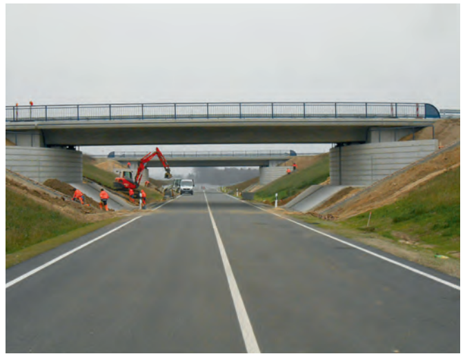
Bauwerke 1a und 1b des oberhalb der B 75 liegenden Kreisverkehr, Blickrichtung Norden
