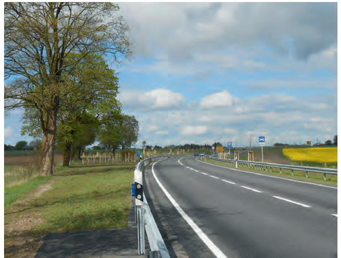
Rekultivierte alte Trasse der B 75 (geradeaus zwischen den Bäumen) und neue Trasse
