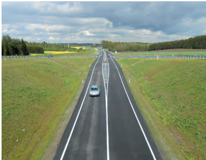
B 75, Blickrichtung Norden mit Holländischen Verbindungsrampen
