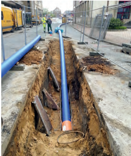
Einzug eines Rohrstrangs beim Rohrliningverfahren
