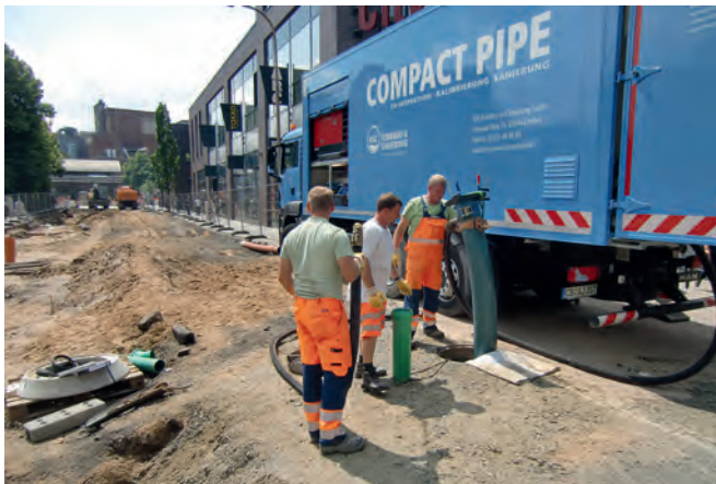
Sanierung mit dem Close-fit-Verfahren
