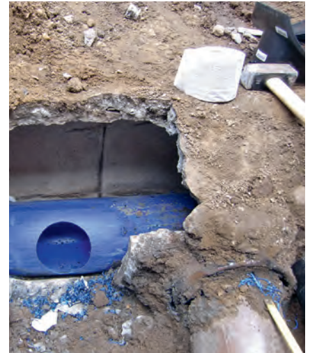
Umbindung der Hausanschlüsse beim Rohrliningverfahren
