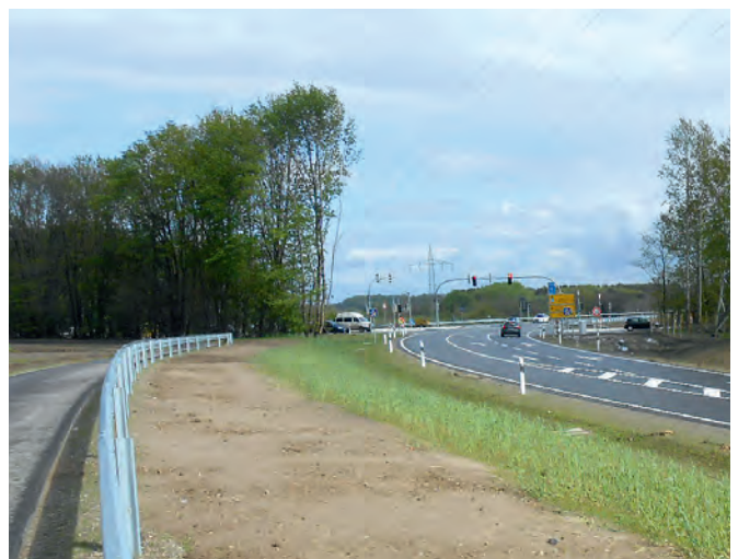
Rampe Knoten 3, Anschlußstelle Dibbersen Nord mit nebenliegendem Wirtschaftsweg
