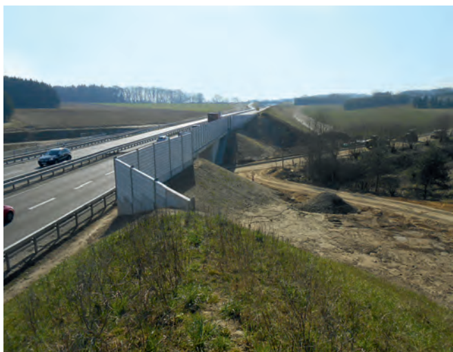
Bauwerk 2, Lärmschutzwand Dibberser Kirchweg
