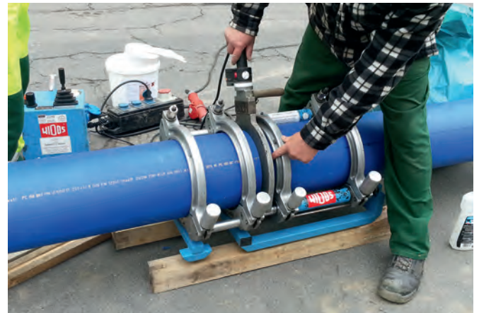
Schweißvorgang beim Rohrliningverfahren
