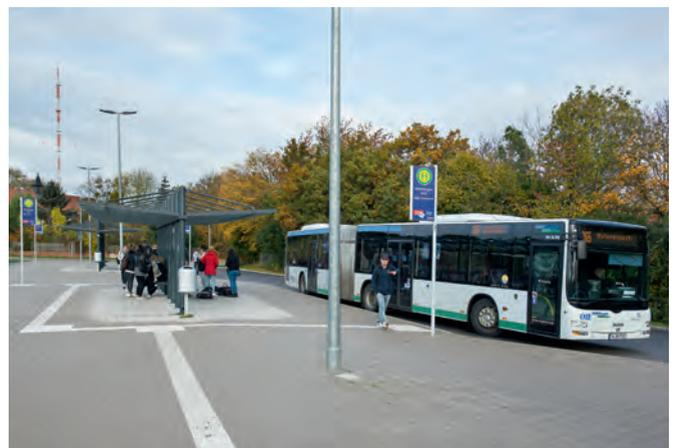
wendeschleife wurde in Beton hergestellt, um den starken Scherkräften, hervorgerufen durch die Kurvenfahrten und das Auslenken aus den Bushaltestellen, gerecht zu werden.
