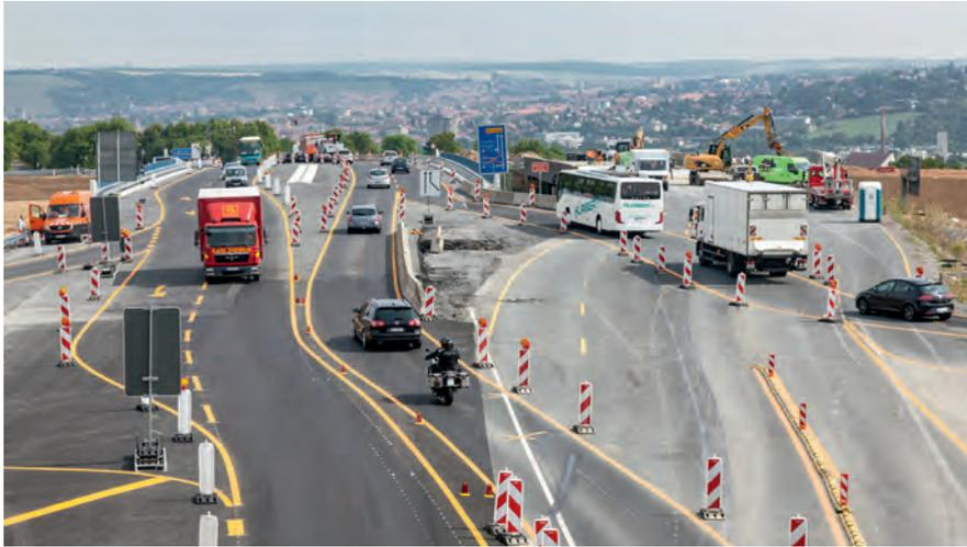
Komplexe bauzeitliche Verkehrsführung mit Behelfsfahrbahn
