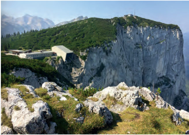
Ansicht der Bergstation
