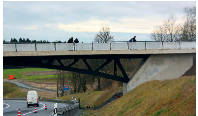
Fachwerk und Widerlager Bauwerk 118b
